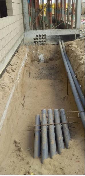
أعمال أنابيب مدفونة
