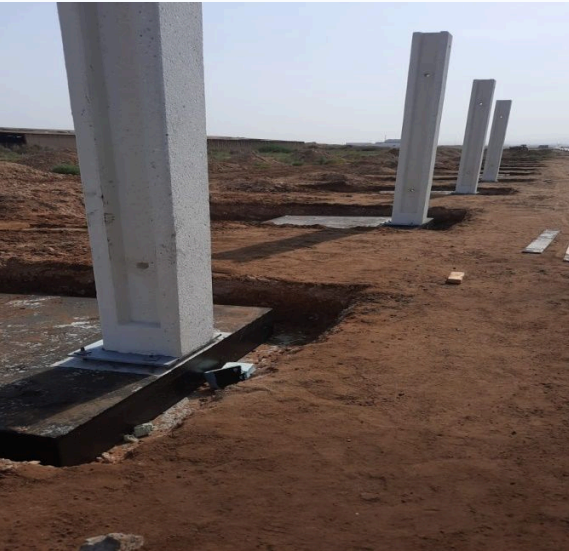
سور سابق الصب أثناء التركيب
