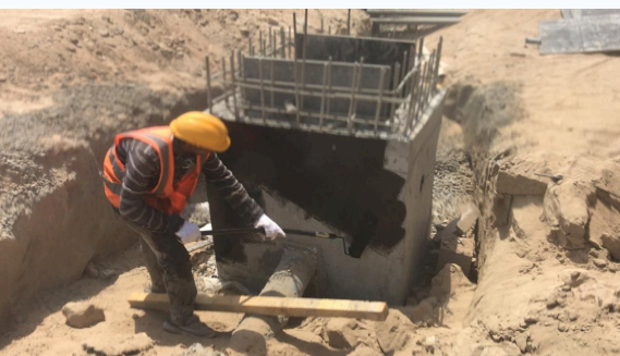
حفر الخنادق والتصريف
